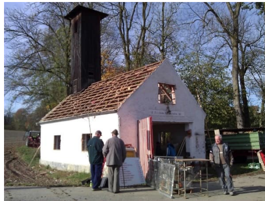
Abriss des Zeughauses 2012
